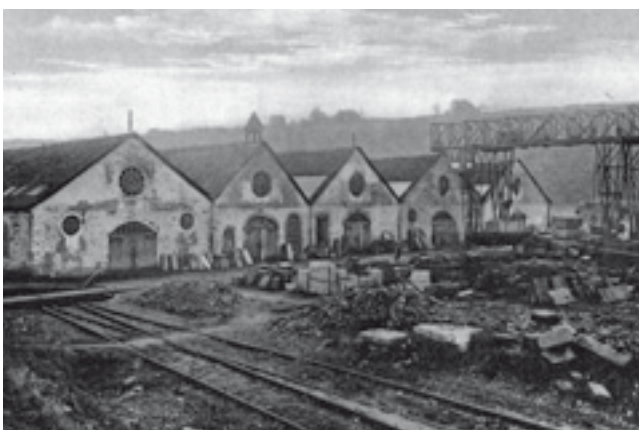
Der Hallenkomplex, der den Lagerplatz der Firma Dassel Naturstein begrenzt, prägte schon 1910 das Bild des Unternehmens.
