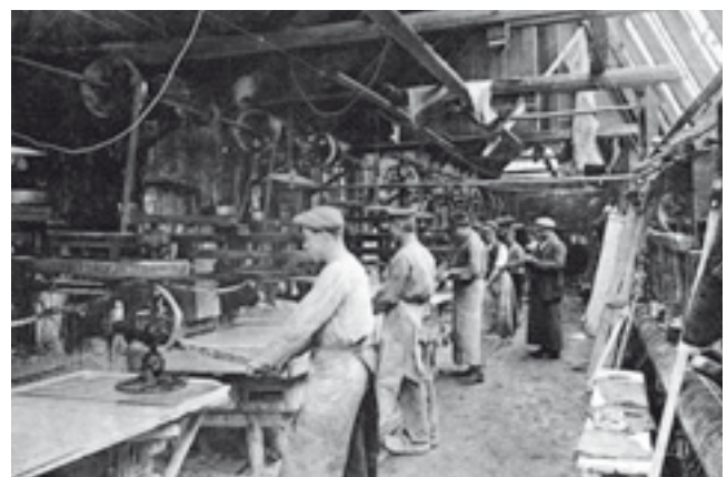
Im frühen 20. Jahrhundert bestimmten v.a. Bauaufträge die Produktion, hier die Maschinenschleiferei. Fotos: Firma
